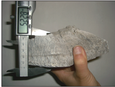
Rysunek 1. Widok z boku na struwit wykrystalizowany w rurociągach oczyszczalni ścieków w Łodzi
