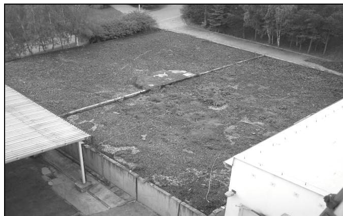
**Fotografia 1.** Zdjęcie powierzchnia ziemnego biofiltra
