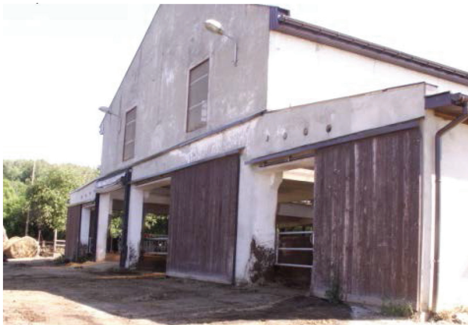
Fotografia 2. Elementy systemu wentylacyjnego a) kurtyny na ścianie północnej, b) kurtyny na ścianie południowej, c) wrota na ścianie zachodniej
