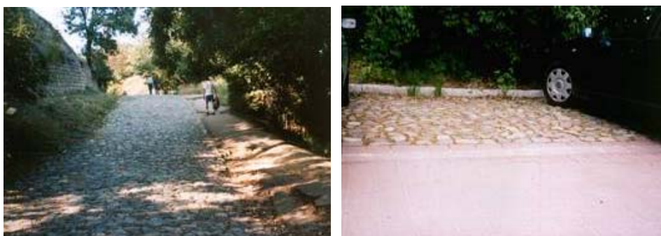
Rysunek 3. Przykłady nawierzchni przepuszczalnych wykonanych z kamienia polnego
