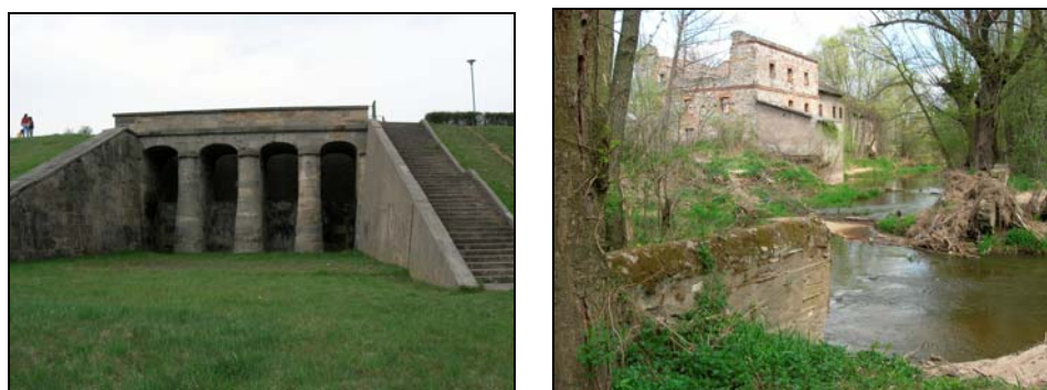
Rysunek 1. Po lewej: pozostałości jazu w Brodach, po prawej: pozostałości młyna i przyczółek jazu w Chmielowie Figure 1. On the left: the old weir incorporated into Brody Dam; on the right: ruins of mill and weir abutment in Chmielów
