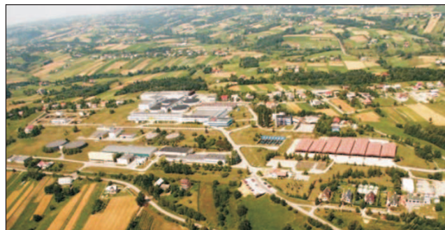
Phot. 19. A bird's eye view of the water treatment plant in Dobczyce (photo: from the database of Miejskie Przedsiębiorstwo Wodociągów i Kanalizacji - MPWiK S.A. Krakow (Krakow Waterworks and Sewerage Municipal Enterprise JSC))
