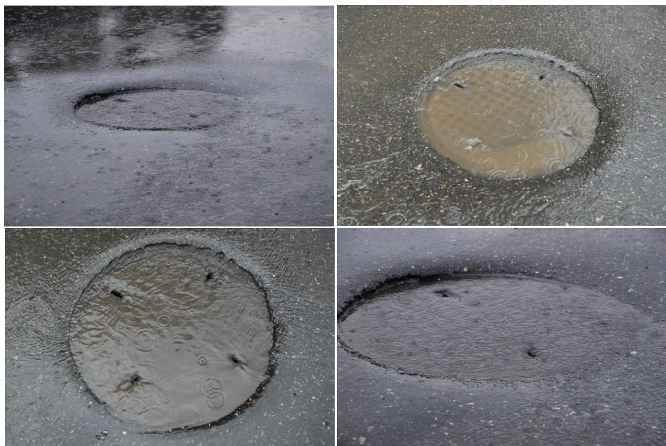
**Rysunek 2.** Przykłady przelewania się spływających wód deszczowych
