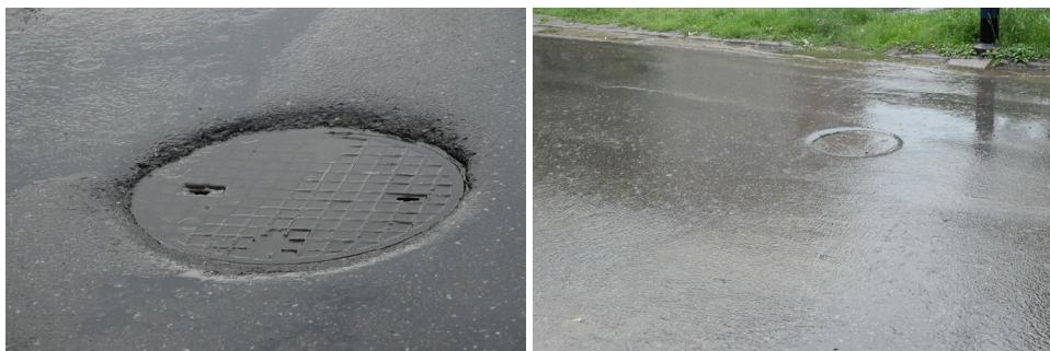
**Rysunek 1.** Przykłady włazów kanalizacyjnych usytuowanych poniżej powierzchni terenu w chwili wystąpienia opadu atmosferycznego
