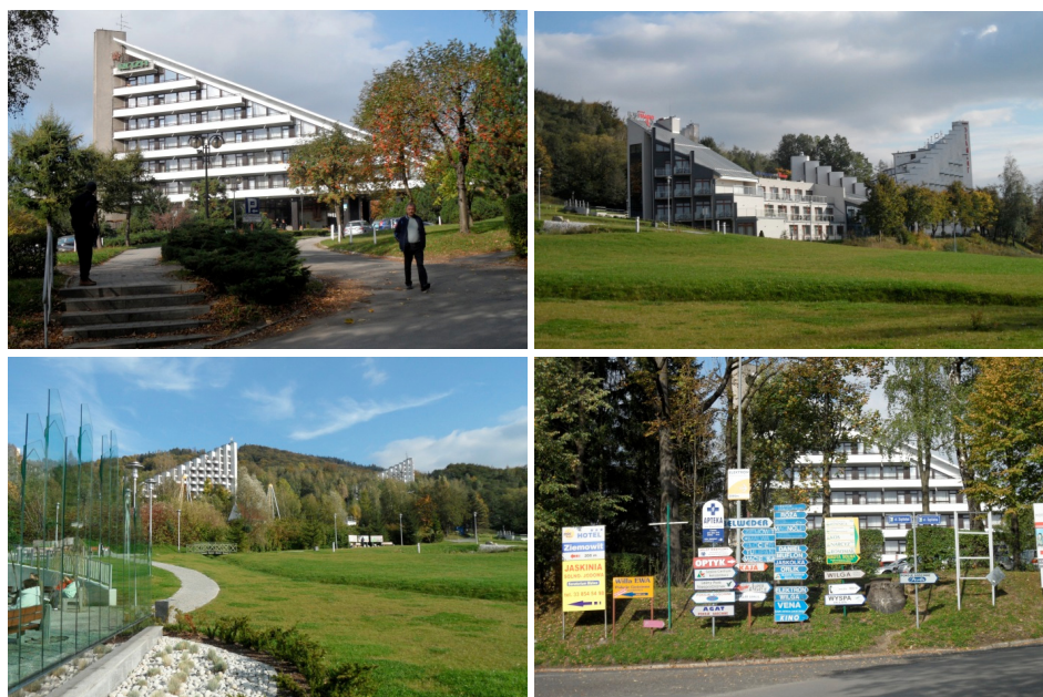
Fotografia 1. Ustronie, budynki sanatoryjne w kształcie piramid (fot. autorki, październik 2012 r.)
