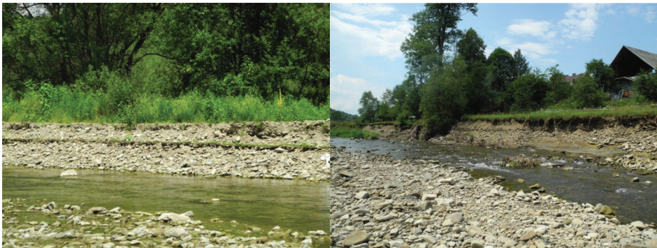
Rysunek 9. Podcięte brzegi potoku na odcinku powyżej obniżonej zapory przeciwrumowiskowej. (fot. A. Lenar-Matyas)
