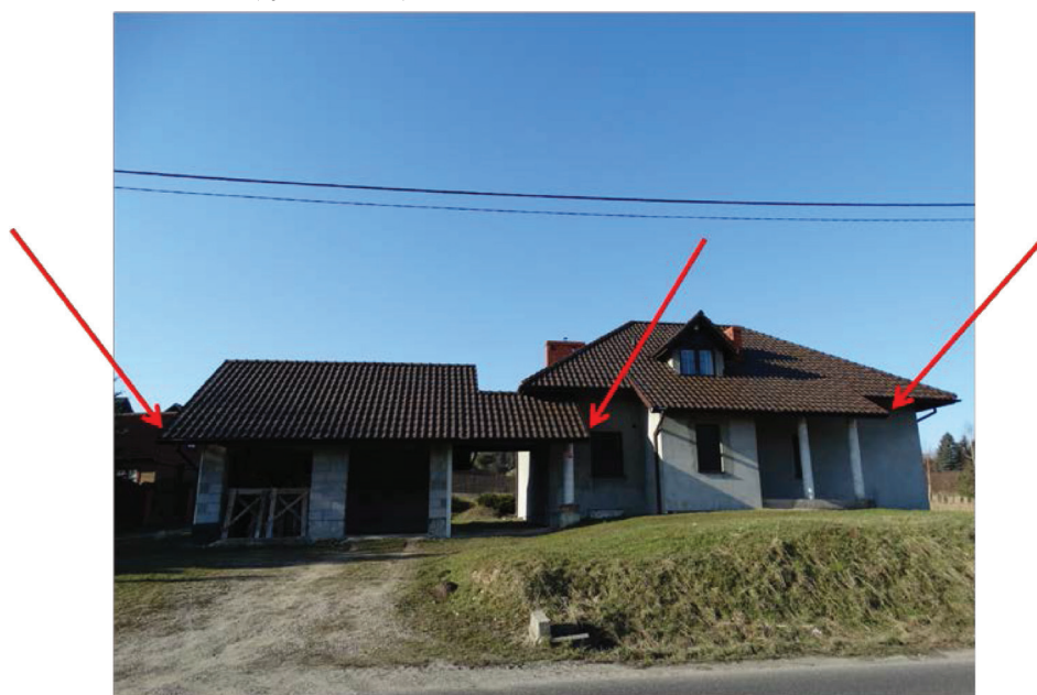
Rysunek 10. Przykład budynku z dachem opartym na filarach (autor: Małgorzata Buśko)
