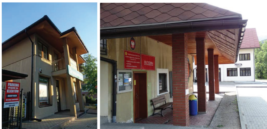
Rysunek 9. Przykłady budynków, w których dach jest oparty na filarach (autor: Małgorzata Buśko)
