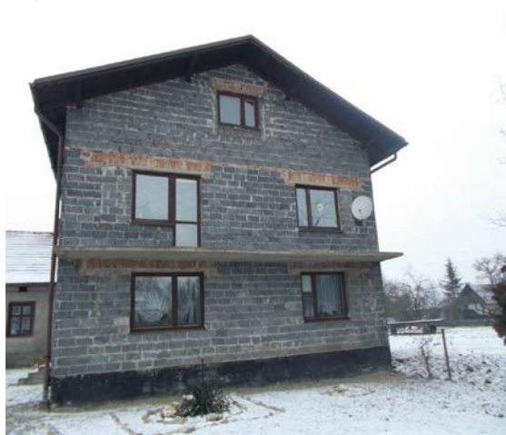
Rysunek 2. Ściany budynku jako przedłużenie ścian fundamentowych (autor: Małgorzata Buśko)
