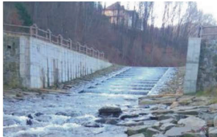
Fot.1. a) Widok na zaporę od strony wody dolnej (2012 rok), (fot.J.Jeleński); b) kaskada przebudowanej zapory (2017 rok), (fot. A.Mączałowski).
